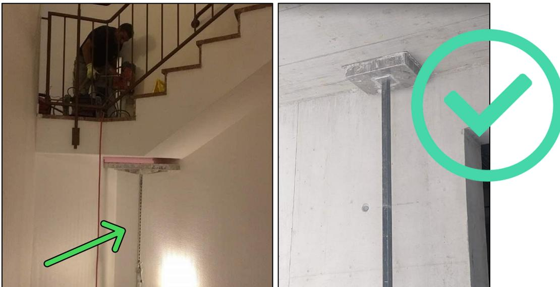
Bei Kernbohrungen durch die Decke müssen die Decken soweit frei sein, damit wir eine Kernfangwanne mit dem Maßen 50x50 cm spannen können. Abgehängte Decken müssen zurückgebaut sein. Ansonsten ist kein Wasserschutz möglich
